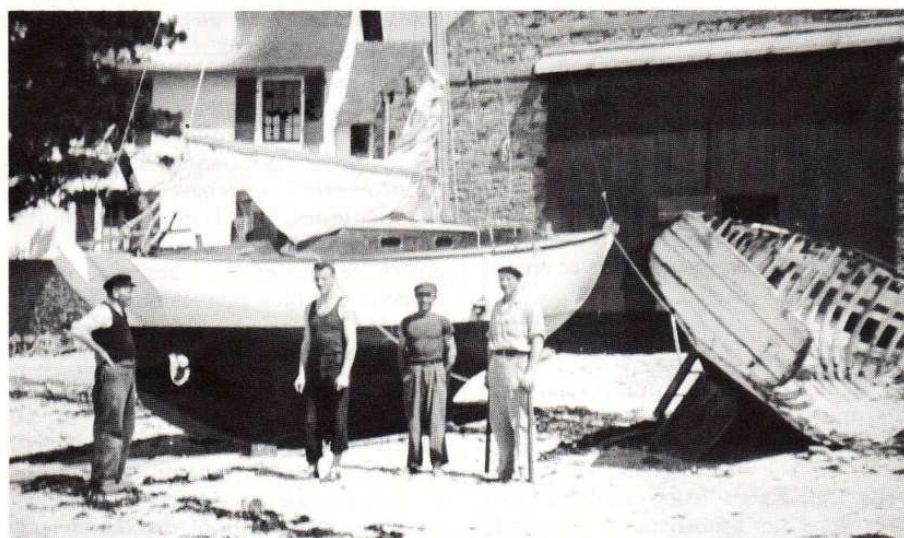
Image symbolique d'une époque de transition : à droite, la carosse d'un cotre de Carantec, très représentatif du type traditionnel local ; à gauche, un 7 m 50 Sergent flambant neuf, du genre des jolis petits sloops marconi à tableau qui feront la plaisance classique d'après-guerre en Bretagne.
